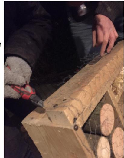
Abbildung 18: Draht befestigen
